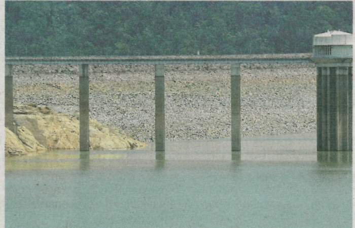
EMPANGAN Sungai Selangor di Kuala Kubu Bharu membekalkan 60 peratus air terawat bagi penduduk Lembah Klang.
