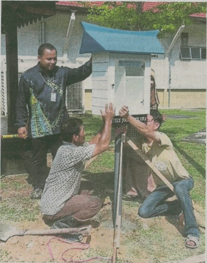
Keja-kerja pemasangan LFL di sekitar kampus USIM.
