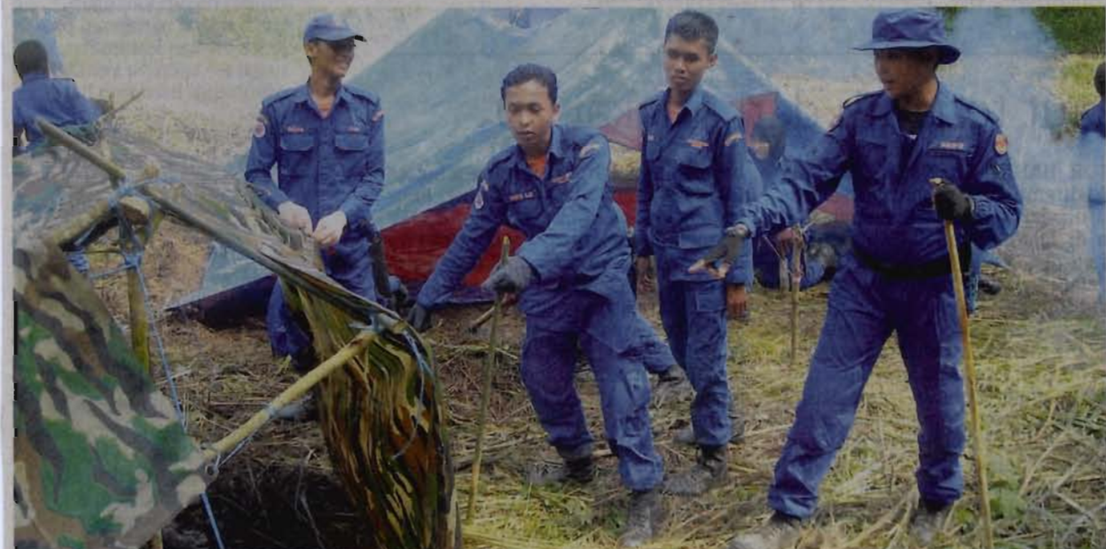
SEBAHAGIAN anggota Sispa USIM bergotong-royong membina tempat perlindungan di Jeram Enggang, Kampung Ulu Jelebu, Negeri Sembilan, semalam.
